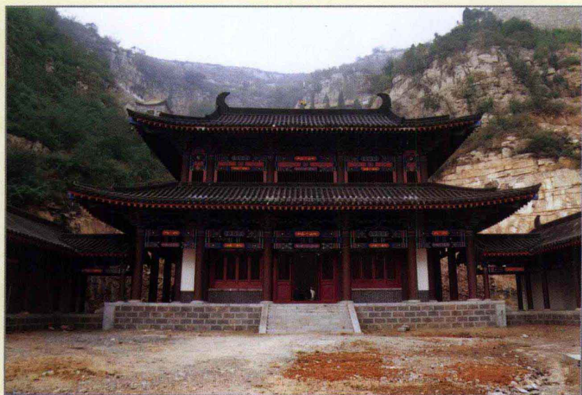
◀2004年7月，五岩山旅游景区新建的药王大殿主体工程完工
