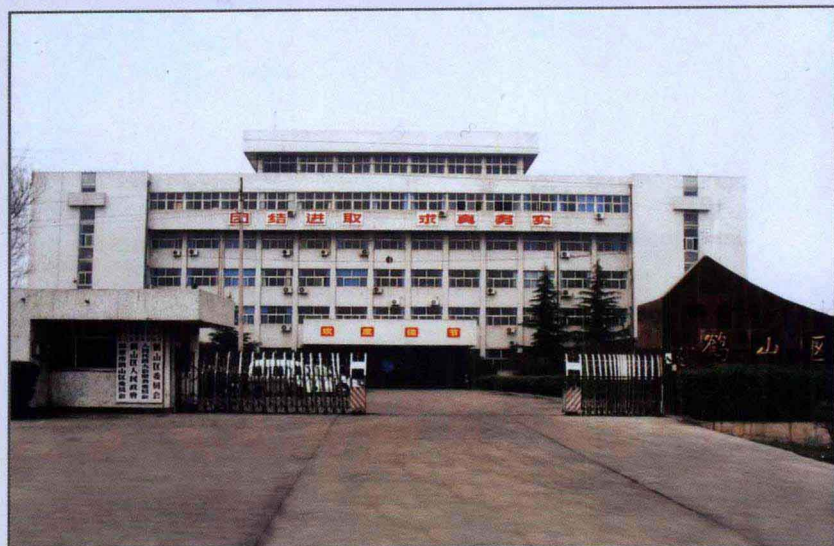
◀ 1993年9月，鹤山区委、区政府综合办公楼建成投入使用
