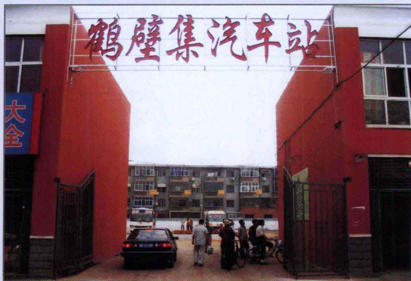
◀ 2004年3月建成的鹤壁集汽车站
