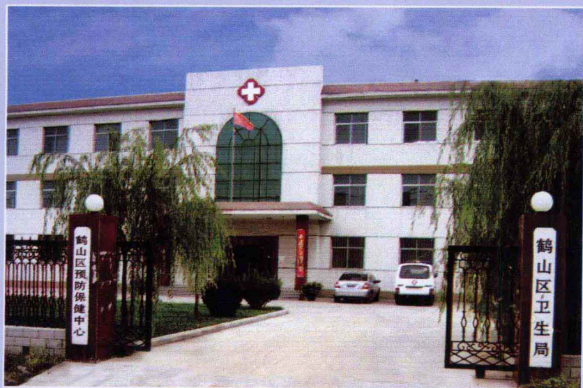
◀ 2002年7月，新建的鹤山区预防保健中心建成投入使用
