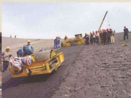
南谷洞水库除险 加固工程监理
