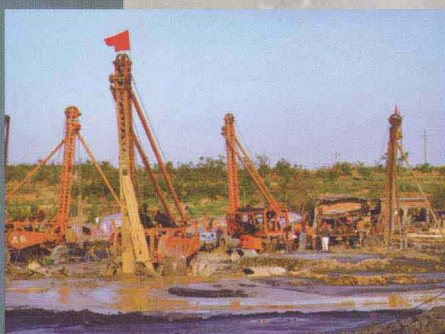
鹤壁二矿精选煤厂房基础处理工程(2004. 5)
