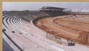
安阳大学体育场工程监理 (2003. 6)
