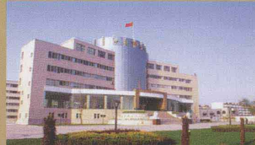
安阳海关大楼工程监理 (2001. 11-1999. 12)
