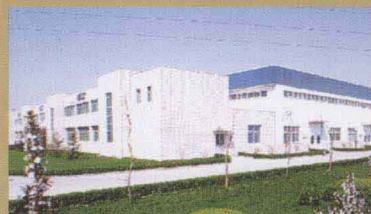
安阳电力开关厂工程监理 (2001. 8)
