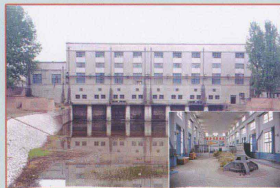
金堤河张庄电排站机房及厂房机组 (1975~1981)
