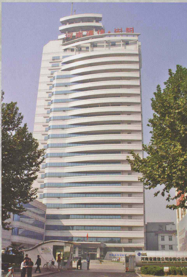
安阳电信综合楼基础支护工程(1997. 4)
