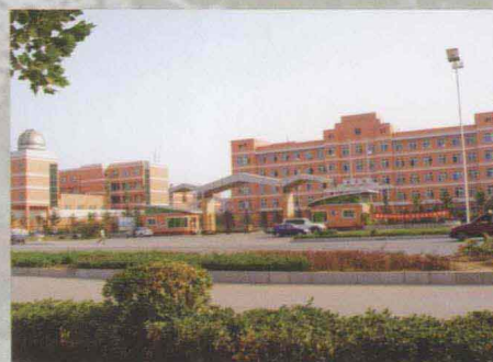
安阳市第五中学工程
