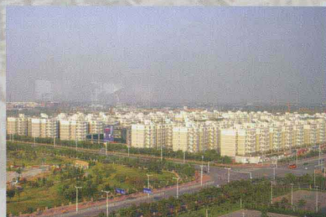
安阳东区公务员住宅区地质勘察(2002. 3)
