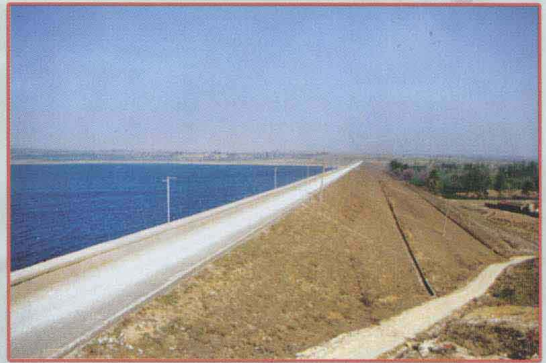
汤河水库除险加固工程(1975)
