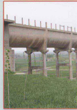
漳南渠总干渠安阳段
