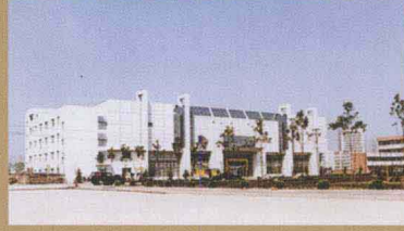
安阳师范学院餐厅工程监理 (2003. 9)
