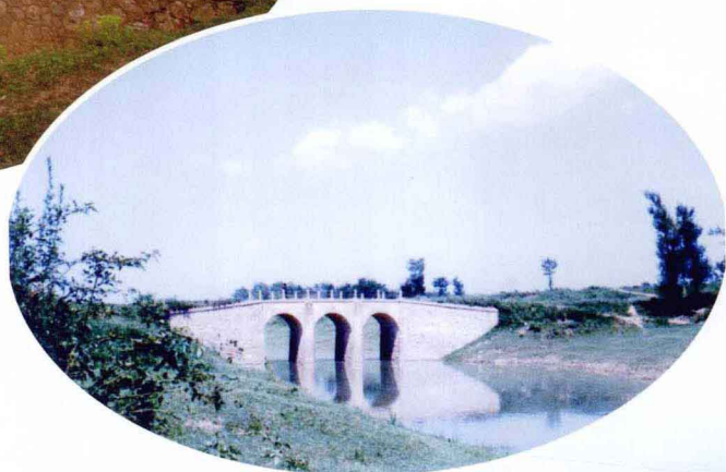
▶ 马良南港红旗桥 (1987摄)
