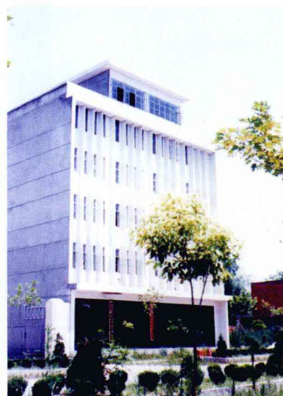
马良工业办公大楼 (1987)
