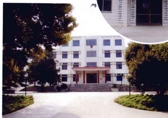
马良镇政府办公大楼
