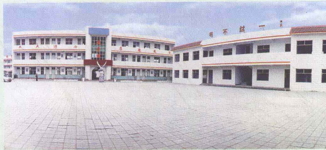
东广场(实验楼·东教学楼)
