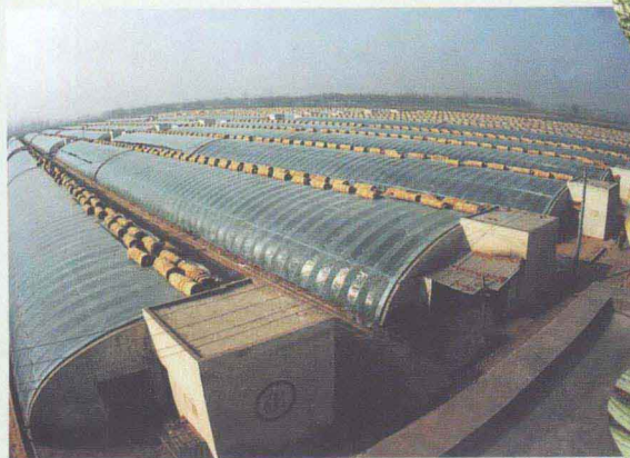
国家级高效农业示范园区 — 兴隆园区温室大棚
