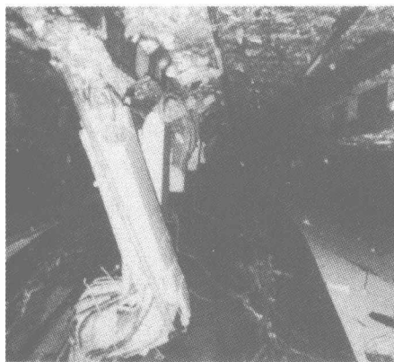
(a) 地铁中柱破坏
