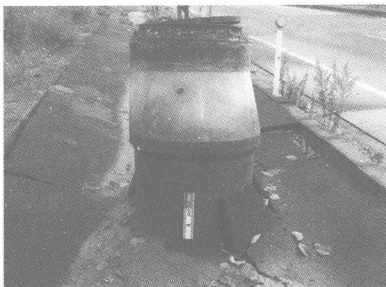
照片 1.2 2004 年新潟地震管井地震液化上浮现象
