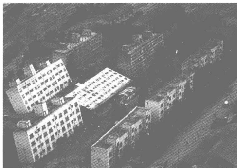
(a) 地基失效, 建筑倾倒
