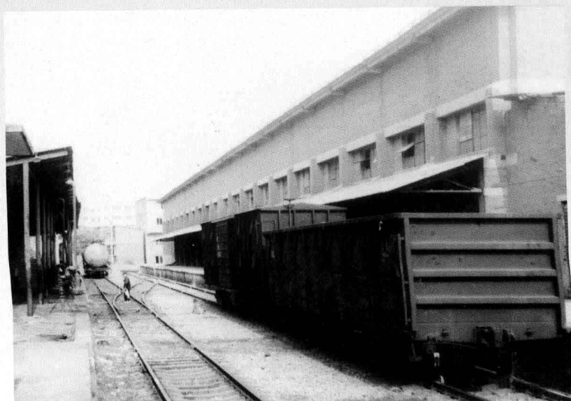
运粮铁路专线
