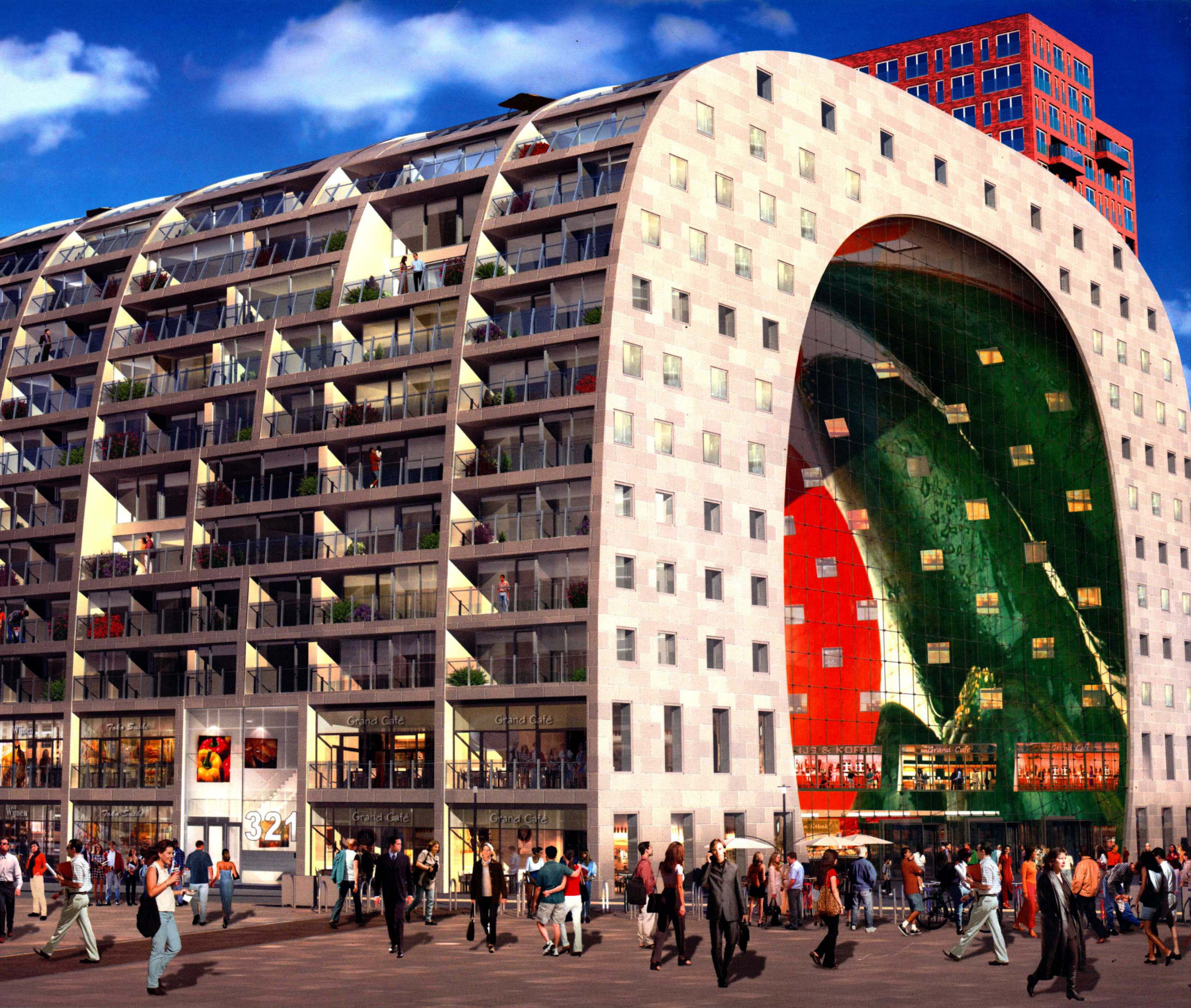
这座拱形建筑共由228间寓所构成，其中有102间用来出租。内部的大型商场包含有100多个市场摊位、商铺、餐馆、1,200个停车位以及一间地下超市。每间寓所的外部都配有阳台和一扇朝向商场内部的窗，同时，这种独立性也可免受外界干扰。40m等宽高的前后门上设计有灵活的悬浮玻璃幕墙，设计者试图用最简单的建筑结构使其保持最大的透明度。同时，商场内部有多种类型的商品在进行销售。
