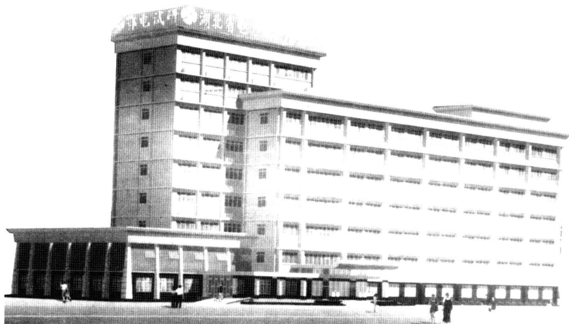
▲ 湖北省电力试验研究院实验和办公楼
