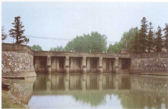
淮涟干渠渠首闸
