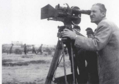
1950 年前苏联水利 专家在三河闸工地
