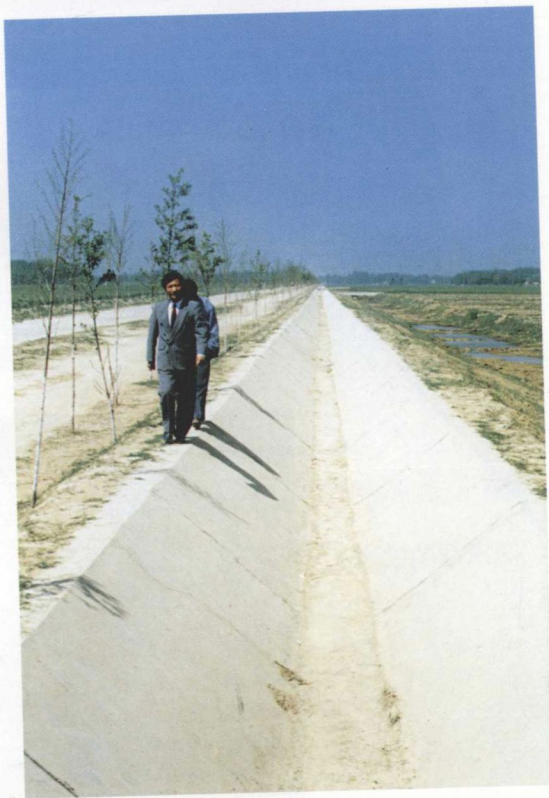
大兴庄防渗渠道
