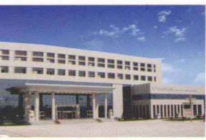
电动汽车产业园办公楼
