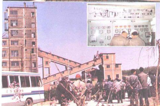
▲ 国家教委所属高校承担并完成的第一个国家重点工业性试验项目——褐煤干馏新技术工业性试验主厂房及主控室。该项技术已通过部级鉴定并转入正式生产
