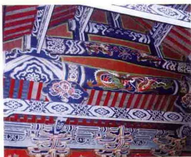
城隍庙大殿梁架结构
