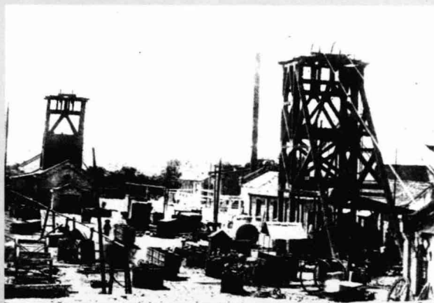
中原公司一、二号竖井。
