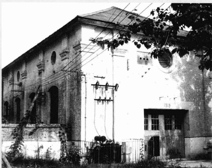
1919 年，福公司建的厂房（位于现焦煤集团神华公司四车间）。
