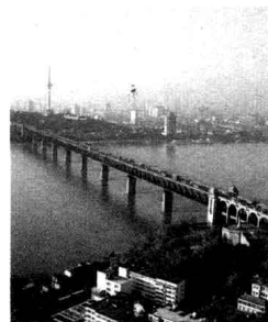
武汉长江大桥
