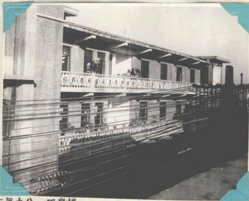
图为厂三层办公、工房楼
