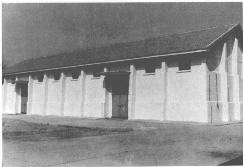
三河尖粮管所80年代新建的仓房
