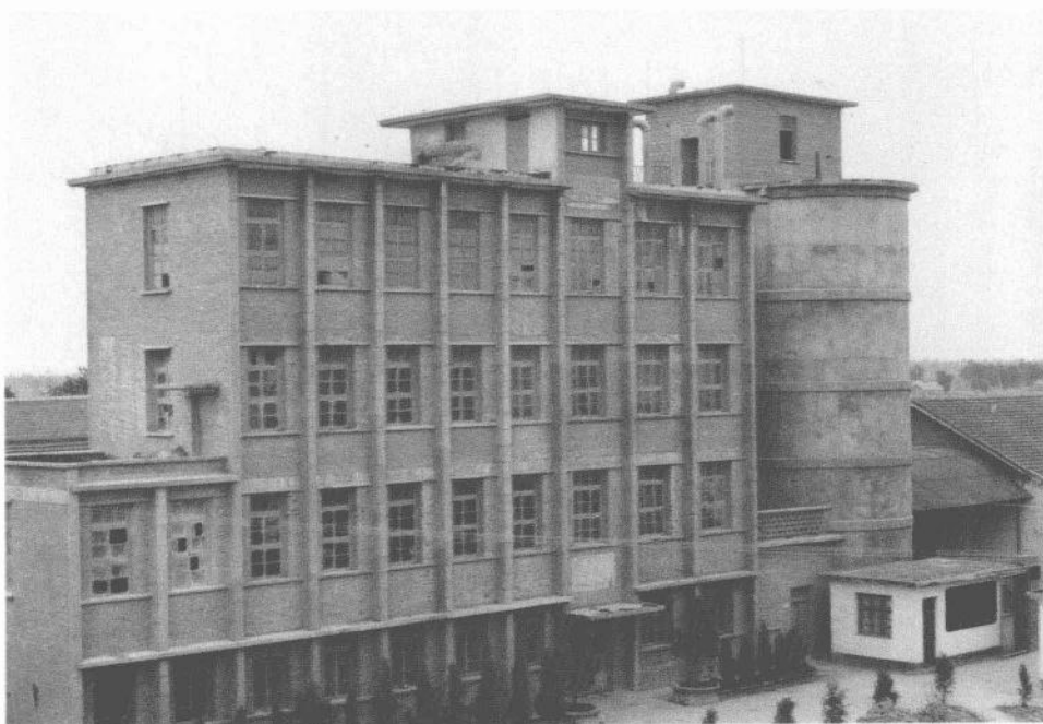
面粉厂主机房
