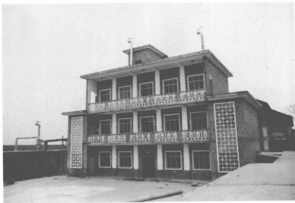
力集粮管所大米厂主机房
