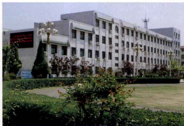
永城市第一小学教学楼
