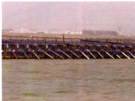
苏州南环东延工程独墅湖围堰抽水
