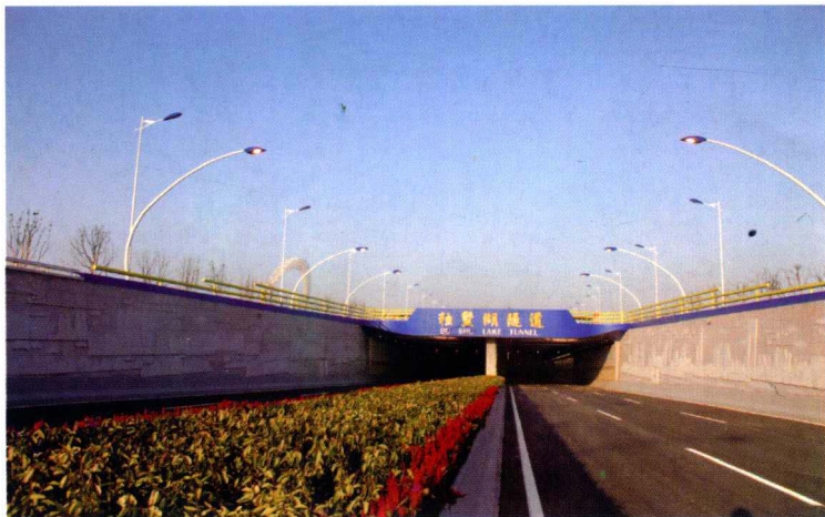
苏州南环东延工程独墅湖隧道入口
