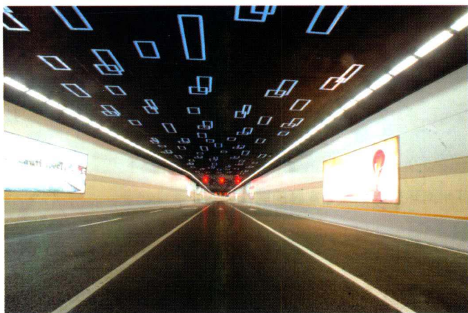
苏州南环东延工程独墅湖隧道内景
