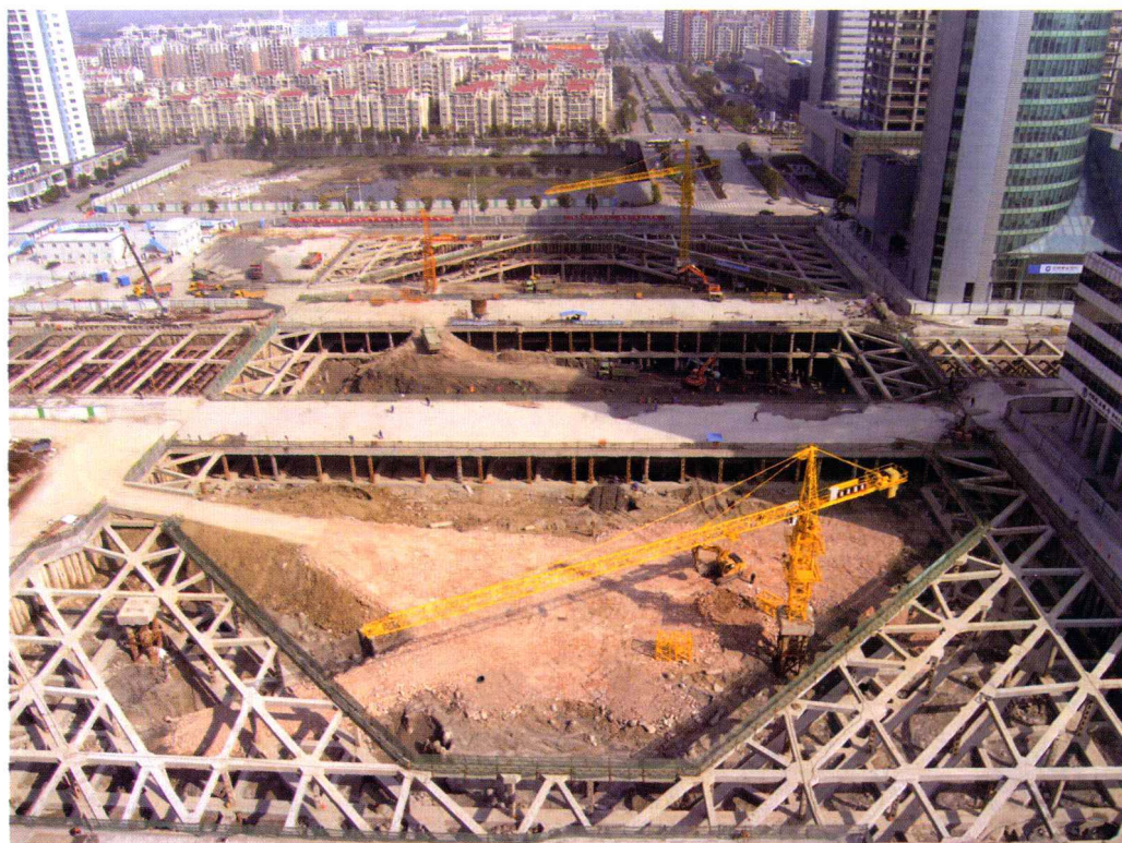
苏州星海街地下空间基坑开挖
