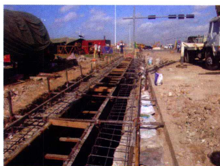
苏州南环东延 工程独墅湖隧 道地连墙围护 结构施工
