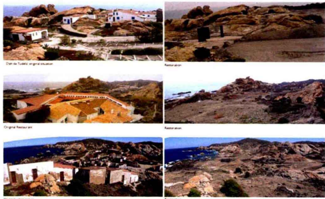
图1-51 图德拉修复工程的现状图
