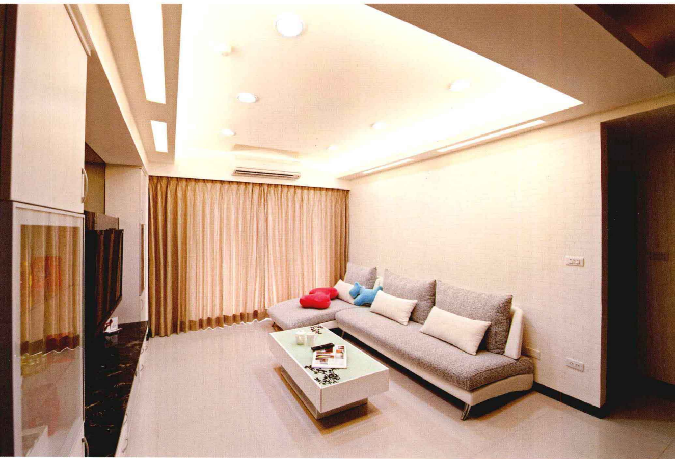
天花照明：间隔长方形开孔，加装喷砂玻璃，让光线能直接穿透至下方。
