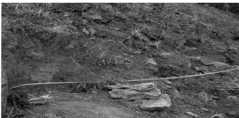
图3 块石夹泥边坡
