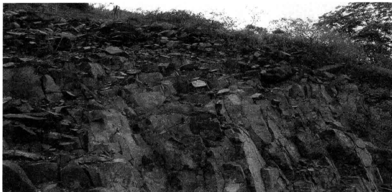
图2 破碎玄武岩边坡
