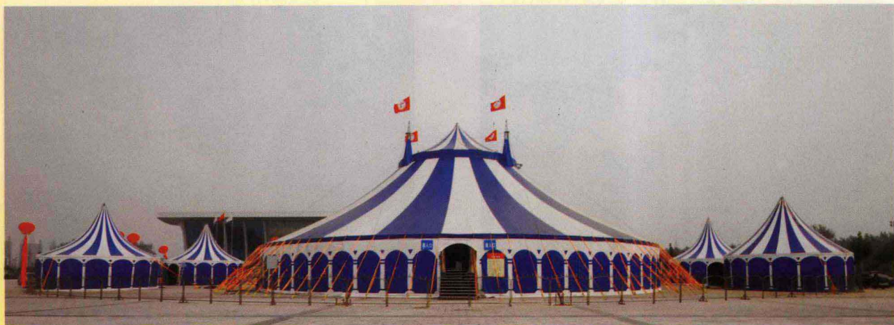
由周口市杂技马戏团演艺设备有限公司研发生产的钢架结构拉膜可移动杂技剧场
