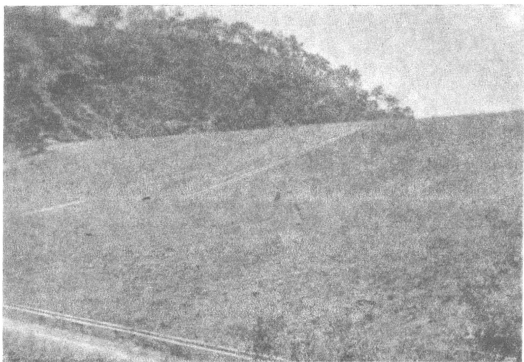
东风水库（中型）大坝背水坡
