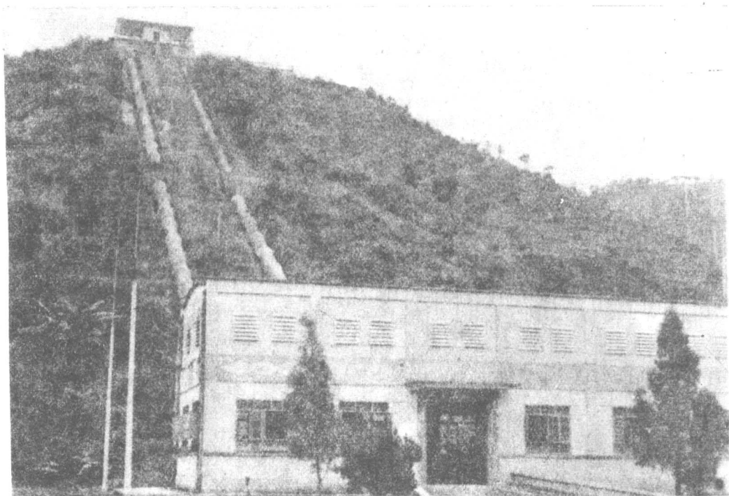
朝阳水库羊孖寮水电站 1980年建
