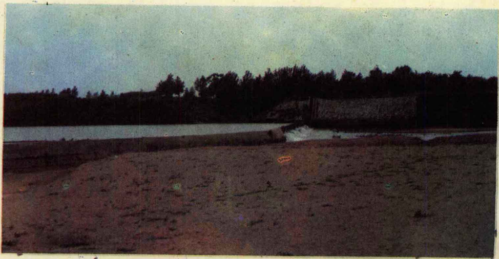
大河屯乡车风灌渠拦河坝
