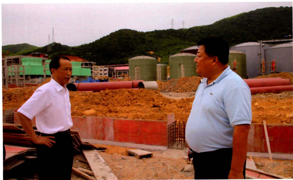
▲ 在司尔特董事长金国清的陪同下参观该公司最新一期生产基地建设工地
