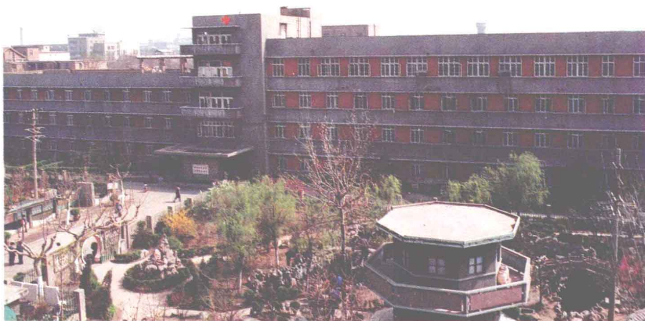
市第三人民医院病房楼及花园
