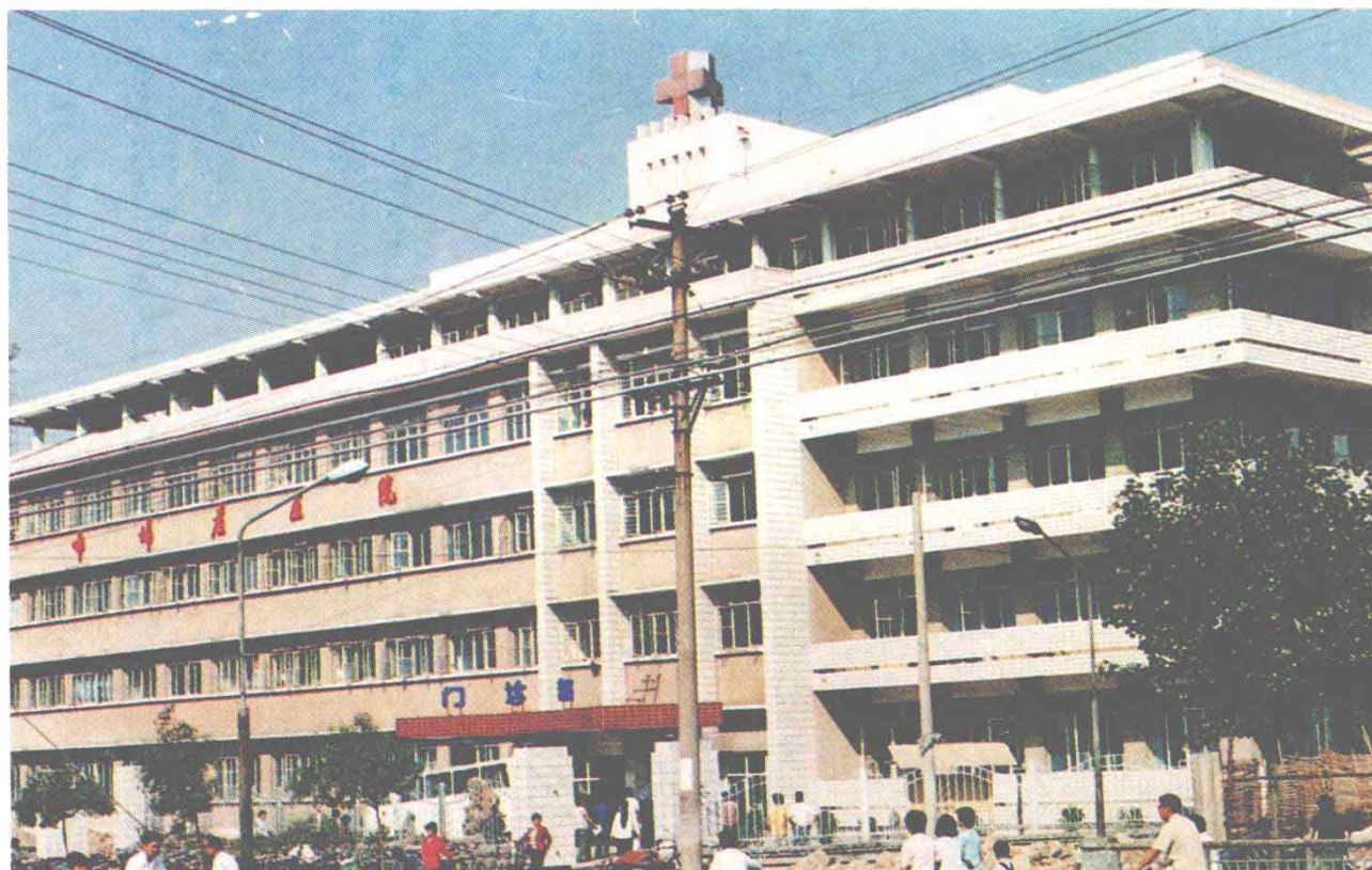
市妇产医院门诊楼
