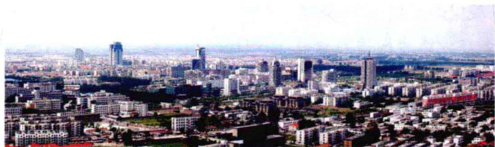
开封部分 城区俯瞰图
