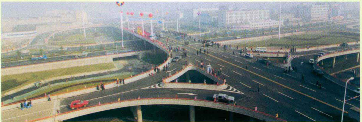
良秋立交桥竣工后，大大缓解了杭城东部交通拥挤的状况。
