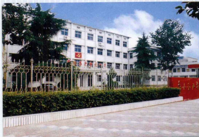
中共伊川县委办公楼
