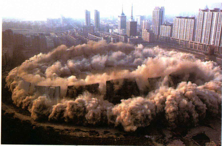
1988年4月1日，沈阳市体育中心土建工程正式破土开工，一期工程总建筑面积77 338m 2 ，总投资一亿元。该工程2007年2月12日15时被成功爆破拆除。
