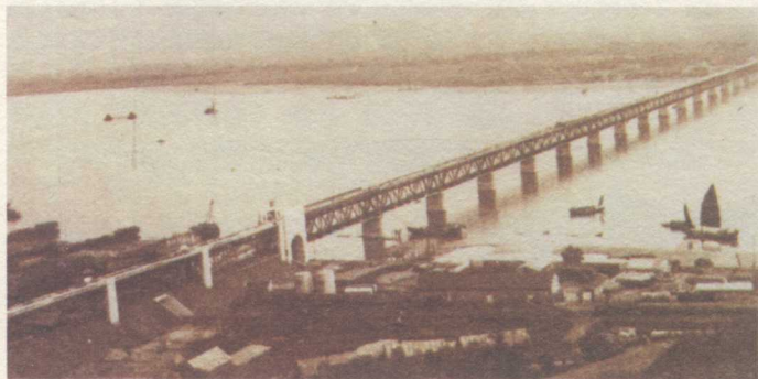
上图是钱塘江大桥，由茅以升设计、中国自己建造的第一座现代化公路铁路两用桥，全长1453米。
