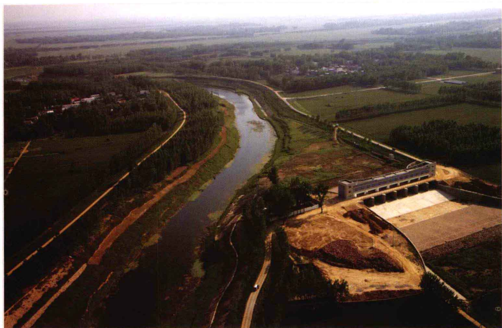
泥河洼滞洪区澧河罗湾进洪闸
