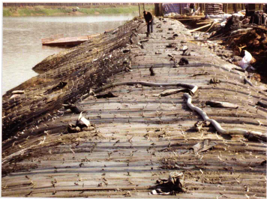
正在施工的模袋混凝土岸坡防护工程
