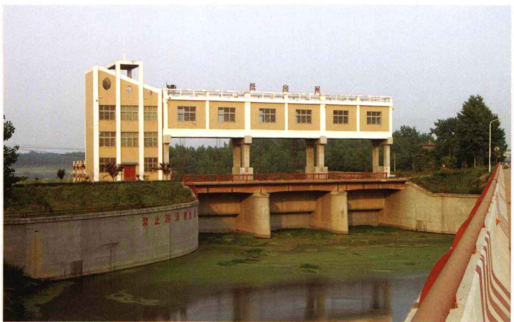
泥河洼滞洪区纸房退水闸
