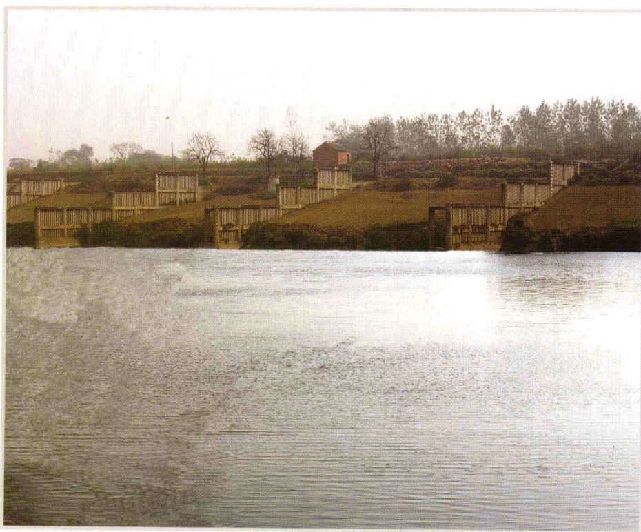
沙河商水县老门潭网格透水坝
