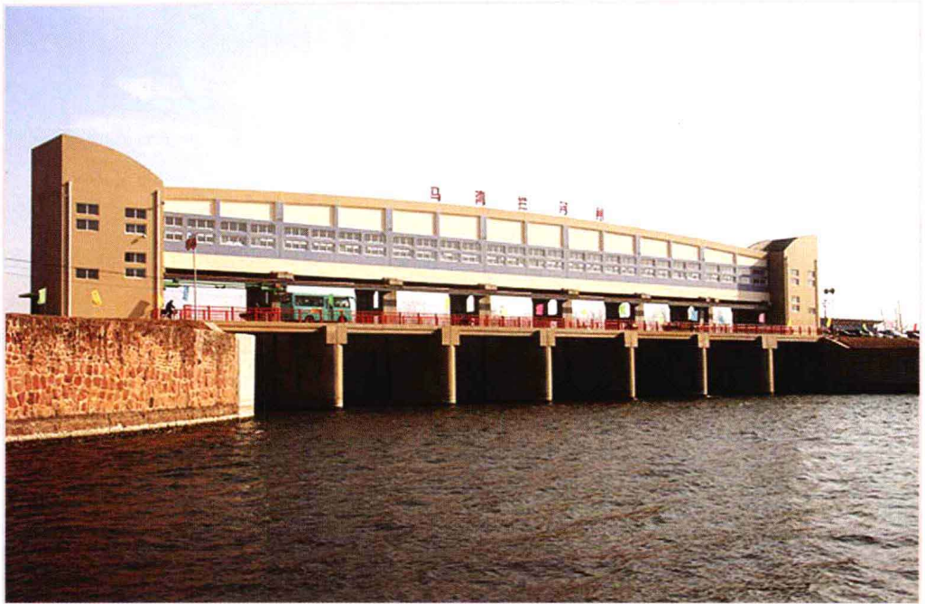
沙河马湾拦河闸
