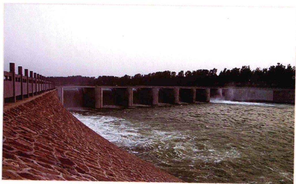
沙河漯河节制闸
