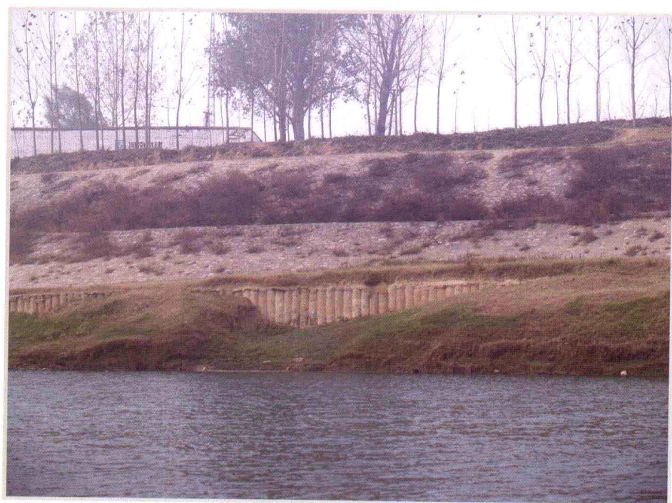
喷粉桩基础岸坡防护工程
