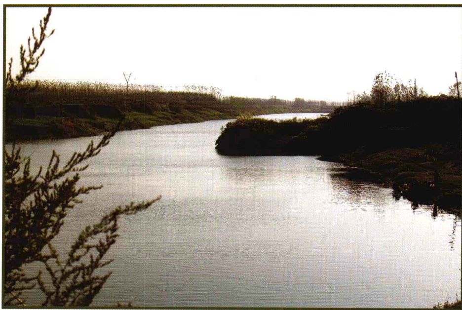
澧河源汇区妖潭斜丁坝
