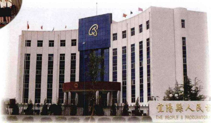
现代化办公大楼
