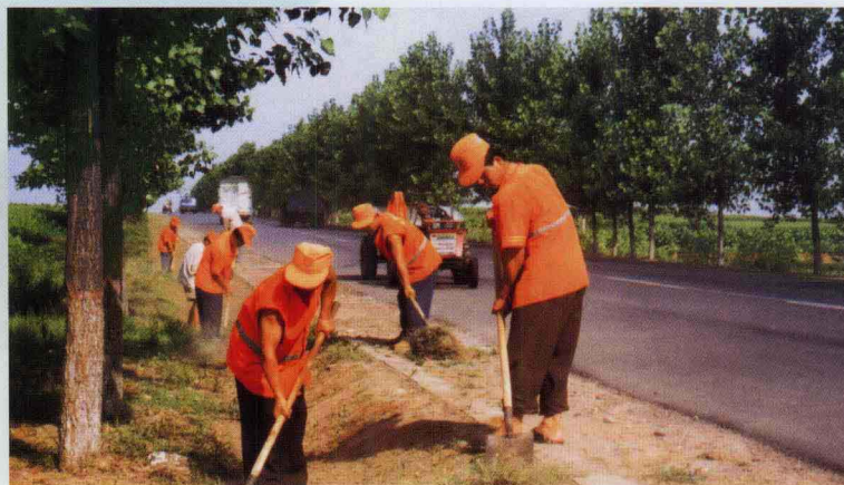
养路工人在精心培护公路路肩、边沟
