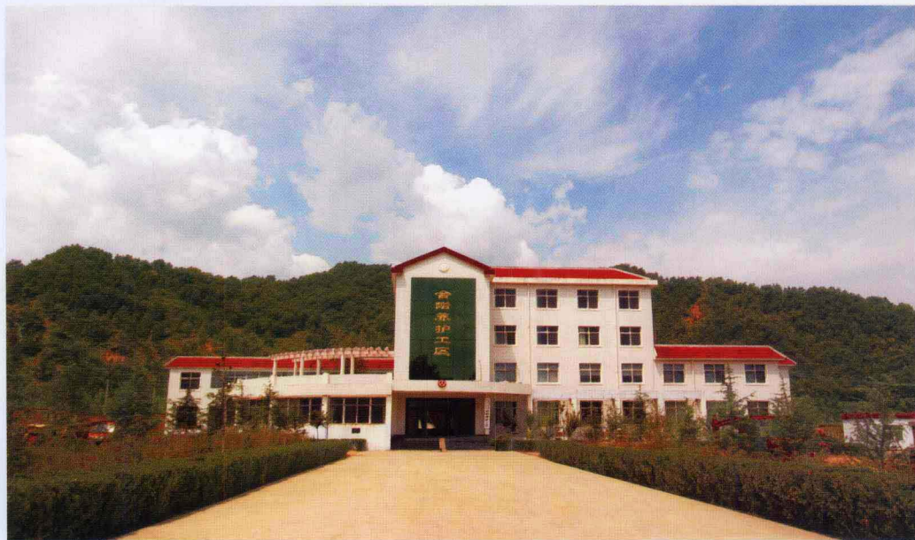
深山里的公路养护道班——栾川合峪养护工区
