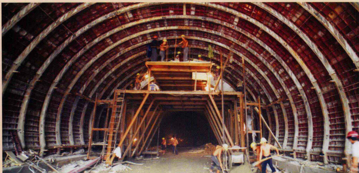
洛栾快速通道前范岭隧道在紧张施工
