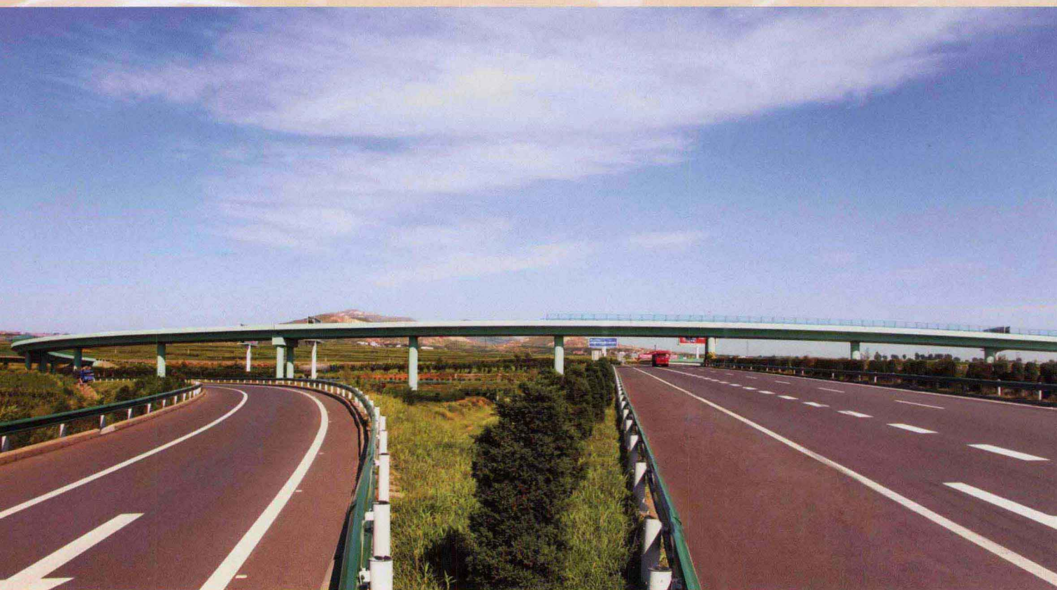
郑少洛高速公路洛阳伊川彭婆立交枢纽
