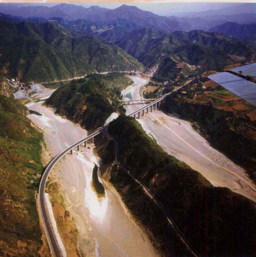
坡、彎多型的前河1號大橋、2號大橋，與前河2號大橋並列的為1969年修建的前河雙曲拱橋
