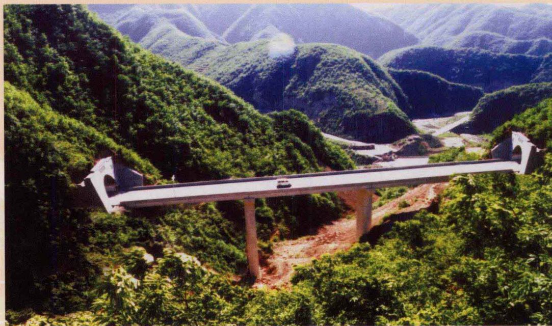
洛栾快速通道嵩县段桥隧相连奇观
