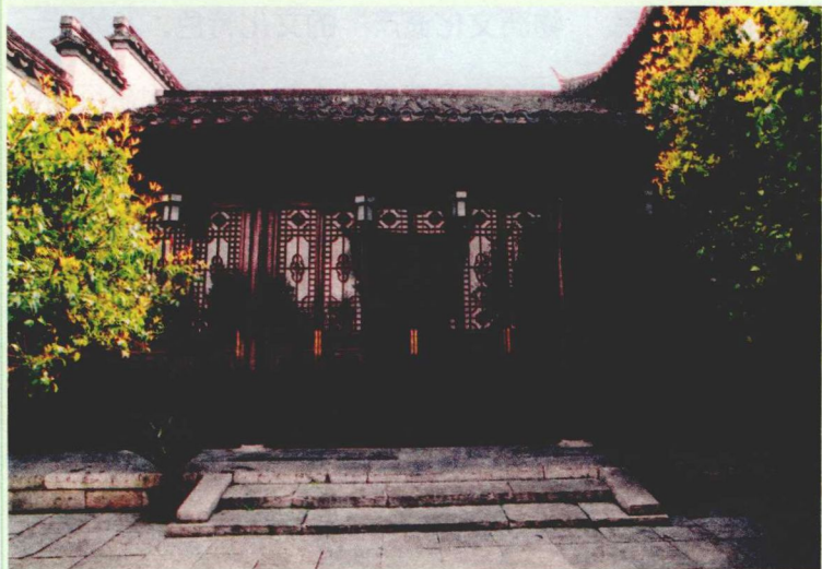
维修后的南捕厅 19 号大厅
