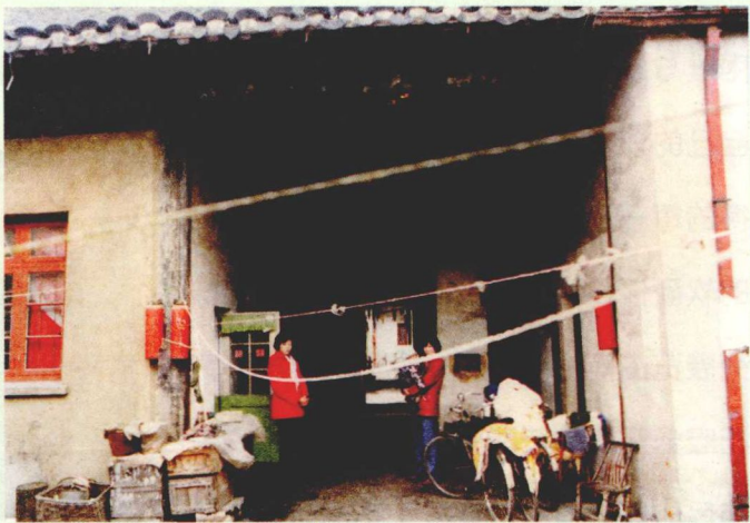
维修前的南捕厅 19 号大厅
