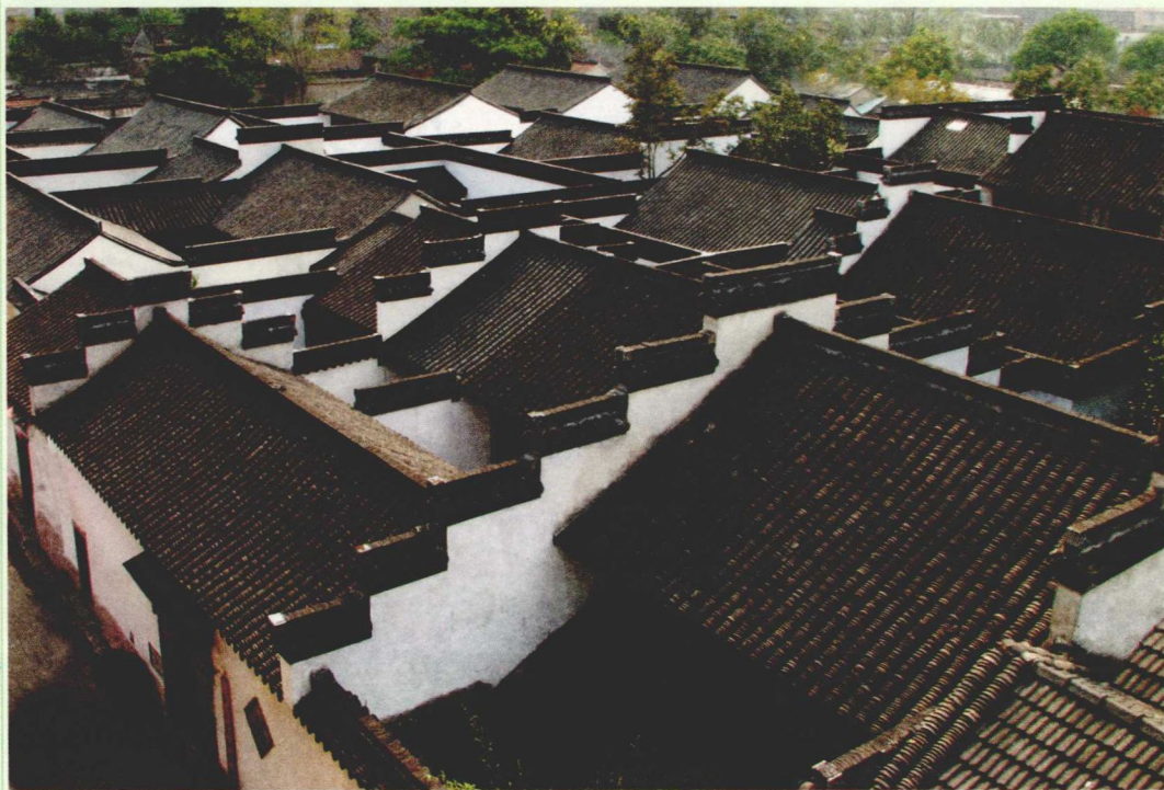
维修后的甘熙宅第
