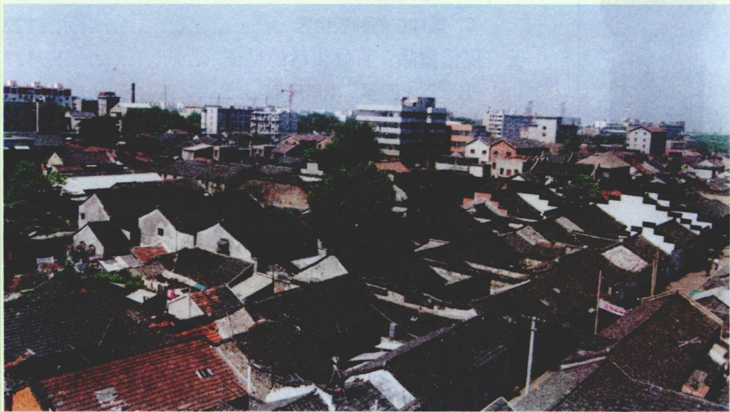
维修前的甘熙宅第
