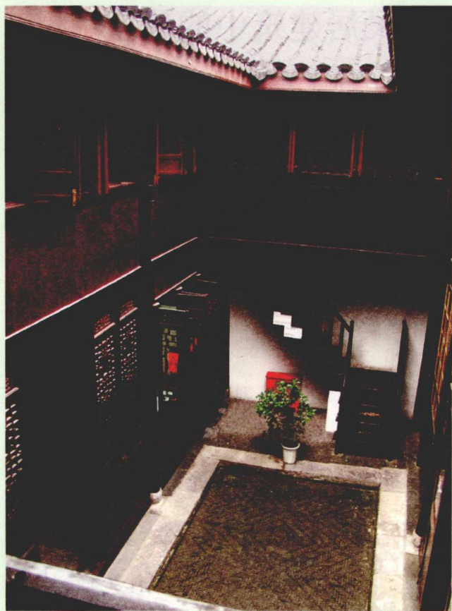
维修后的跑马楼
