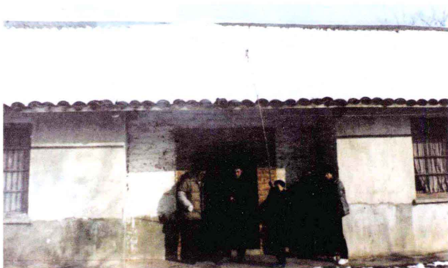
海子童年时期居住的房屋（位于安徽省怀宁县高河镇查湾村），现已拆迁。
