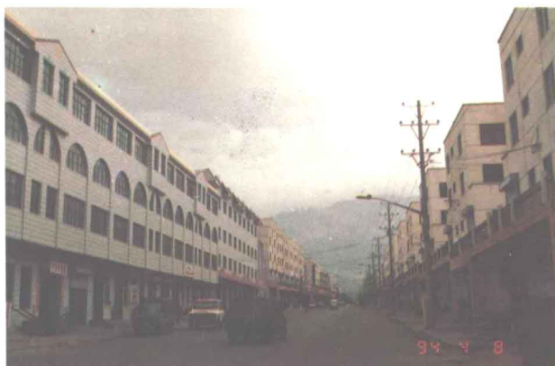
郑州市旧城改造开发公司施工的登封市改造工程
