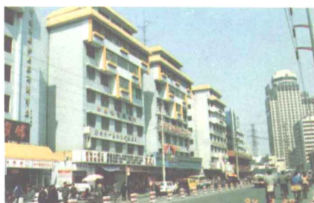
郑州市旧城改造开发公司竣工的一 马路改造工程
