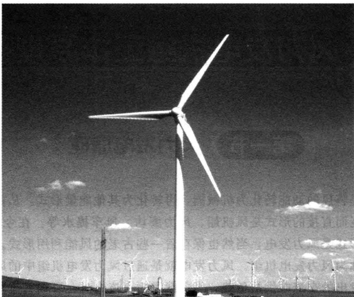
图 1-2 风电场中的水平轴式并网型风力发电机组
