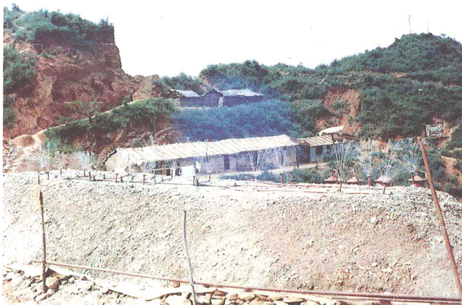
低品位金矿石堆淋现场
