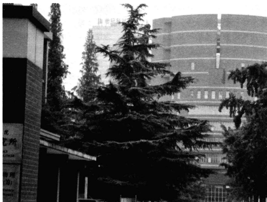
现中科院物理所大楼外景
