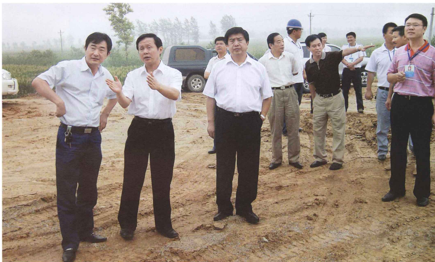
2007年7月27日，驻交通厅纪检组长王晓共（前左二）到安南高速公路工地检查指导工作
