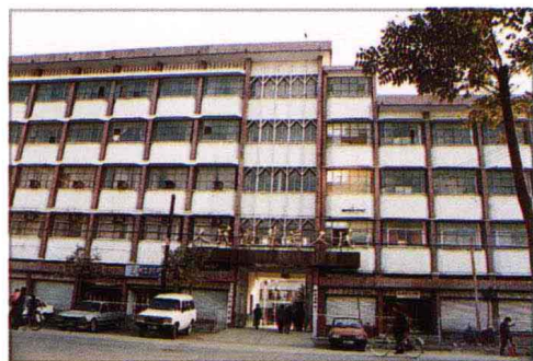
△ 郸城县电业局办公楼
