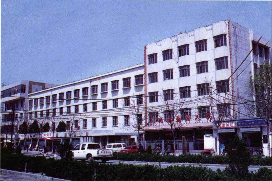
△ 地区电业局办公楼
