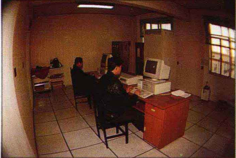
◁ 地区电业局远动室
