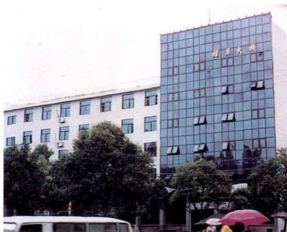
南平地区烟草分公司邵武经理部大楼
