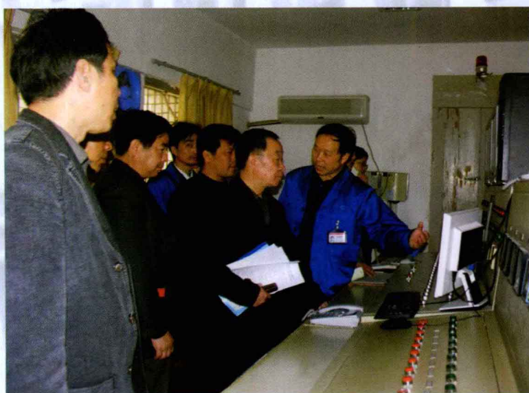
省市专家组视察公司全自动化生产线控制机房
