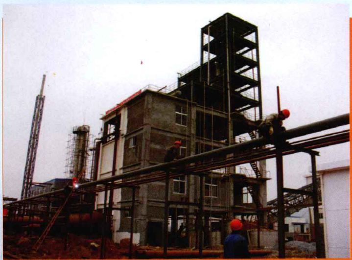
建设中的硝酸铵项目工程
