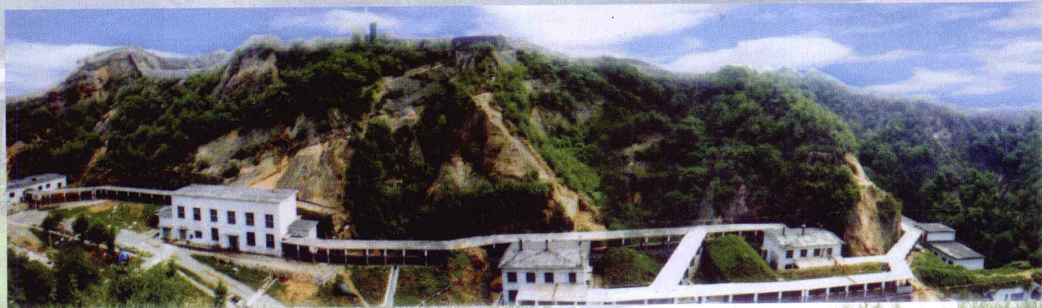
恩施分公司生产线工房全景
