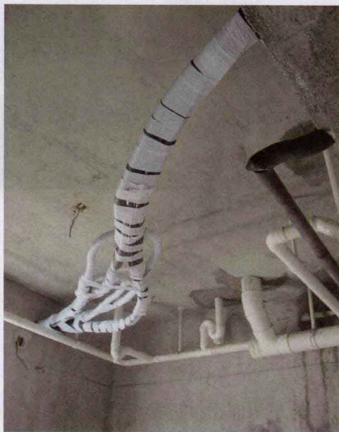
图1—8 做吊顶前的管线安装
