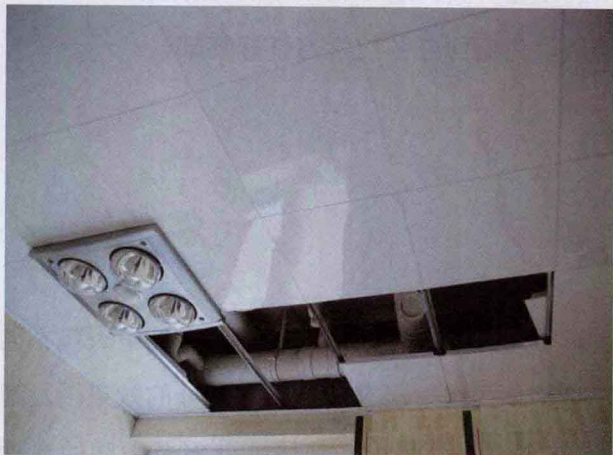
图1—6 卫生间方形铝扣板吊顶解决防潮问题
