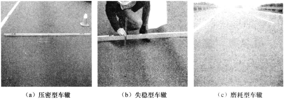
图 2-1 A 高速公路车辙破坏类型典型照片
