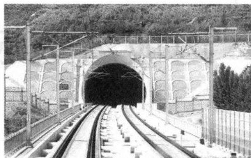
图 1.4 京沪高铁西渴马 2 号隧道边坡
