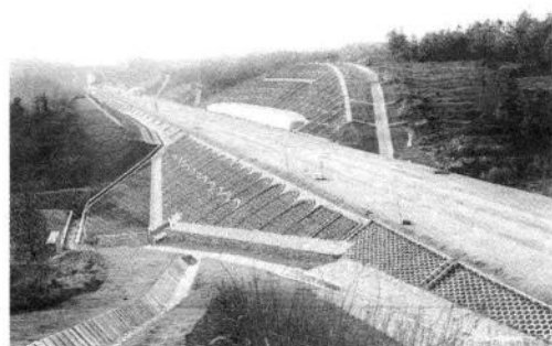
图 1.3 京沪高铁汤山路基边坡
