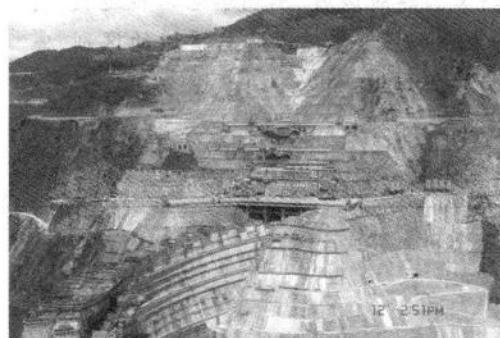
图 1.5 小湾水电站左岸高边坡
