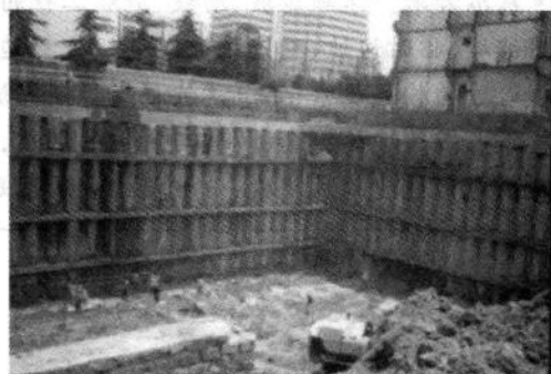
图 1.6 某深基坑支护
