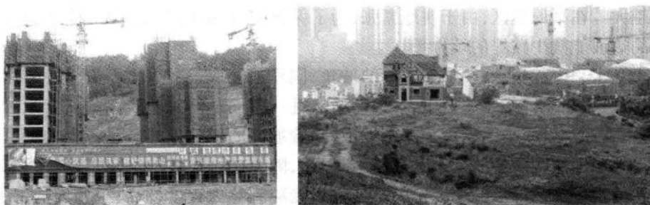
图 1.8 山地城市削坡建房
