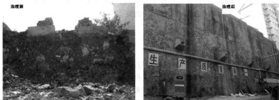
图 1.9 三峡库区巴东县新城区某边坡治理前后对比图
