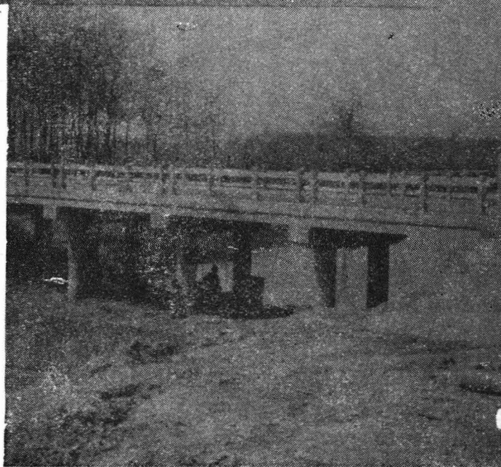
李贯河钢筋混凝土平板桥
