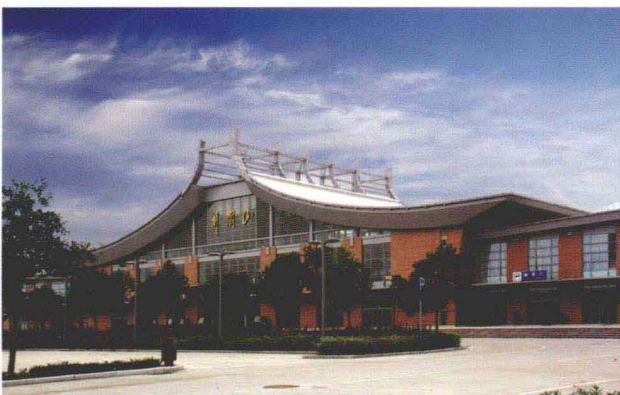
新建铁路井冈山市站工程
