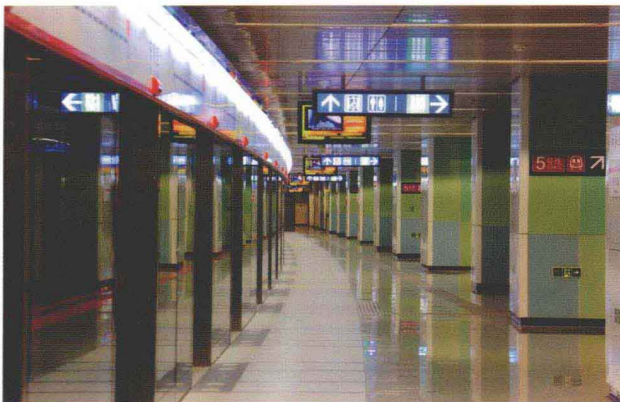
北京地铁五号线工程获2009年度“鲁班奖”
