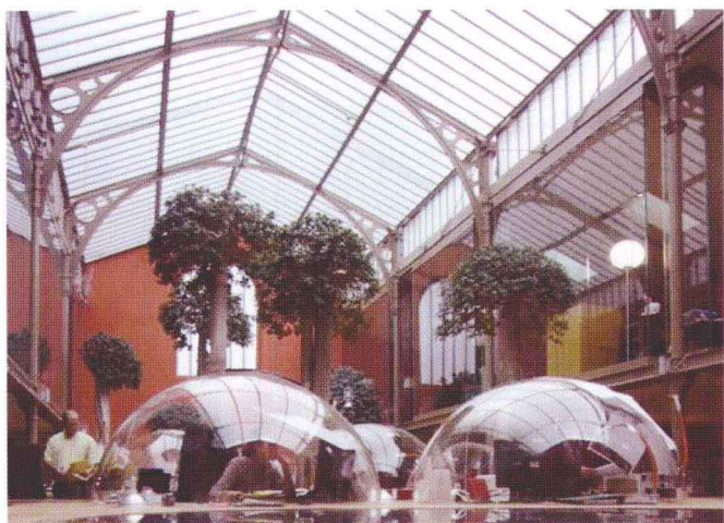
图5-53 钢构架结构及自洁玻璃
